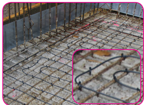
Verwarmingskabel gemonteerd op bouwstaalnet
