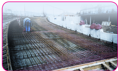
Verwarmingskabel op bouwstaalnet
