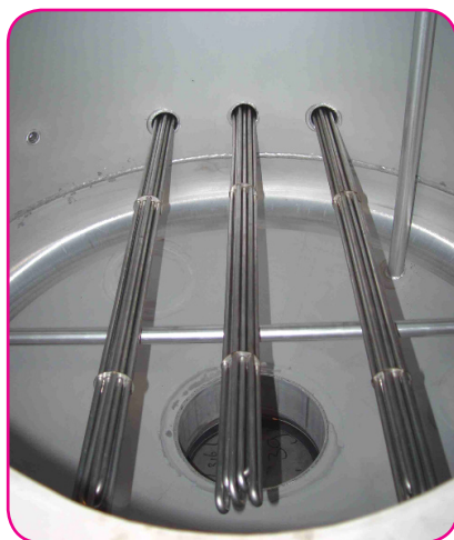
inschroefelementen onder in een RVS tank
